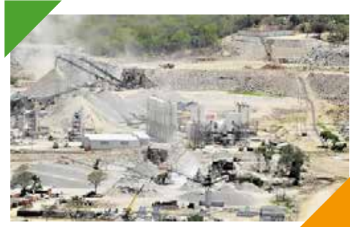
Obres de l'embassament del Renaixement
